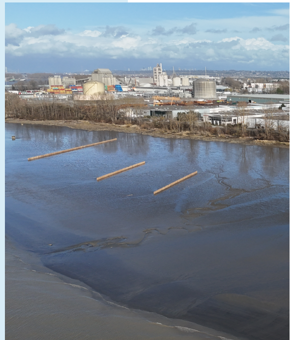
Au-dessus de : Six barrages en pieux de bois et en broussailles récemment construits sur la vasière du secteur ouest de Tilbury, mars 2026
