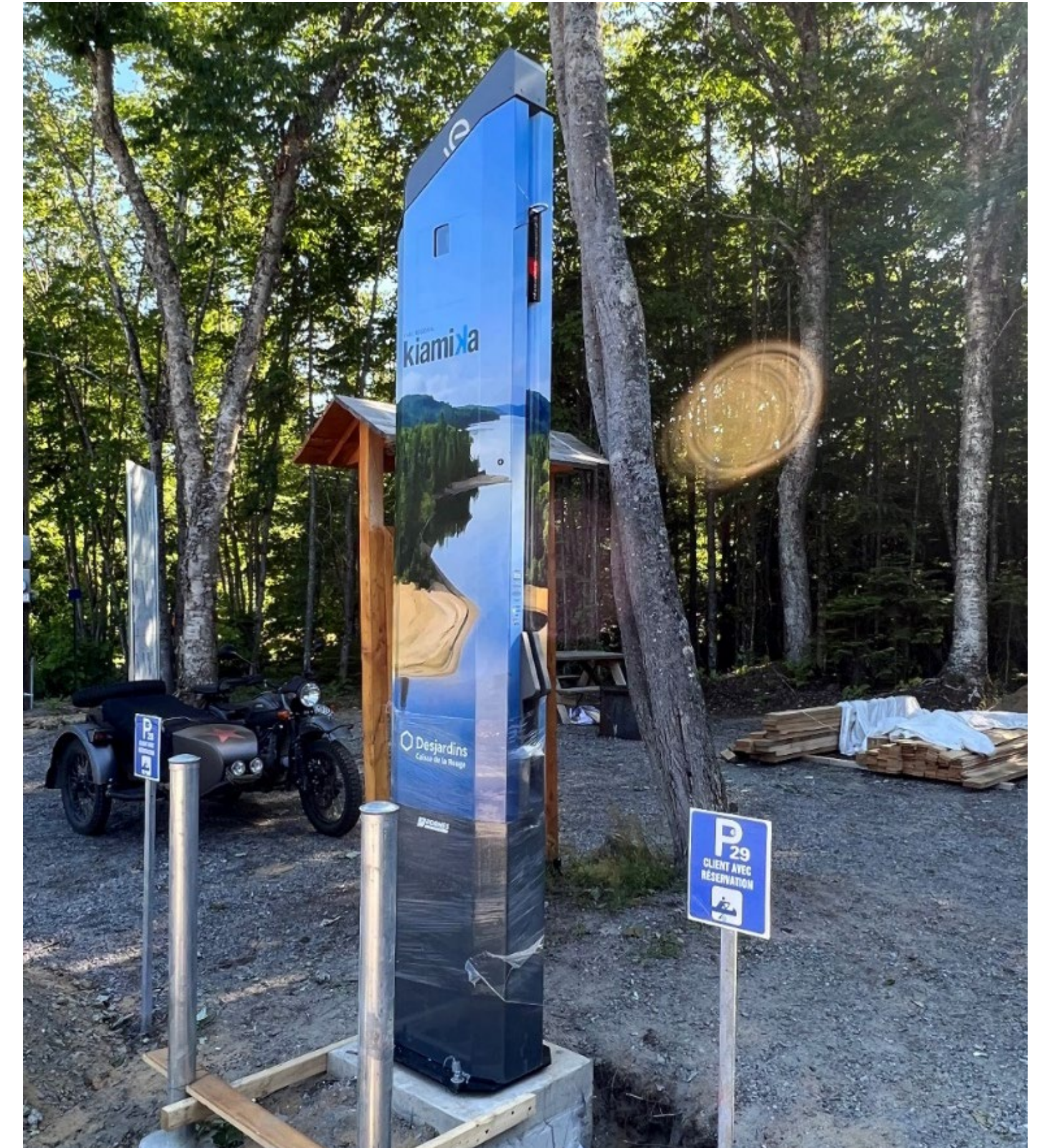
Une borne de recharge niveau 2 en cours d'installation au Parc régional du Kiamika, commanditée par Desjardins.
